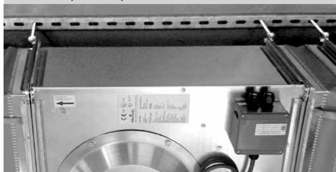
Рис. 9 - крепеж при помощи пластин
