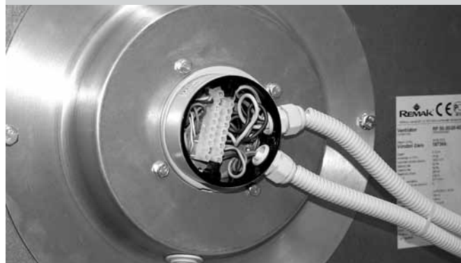
Рис. 12 - пластмас. клеммная коробка на статоре
