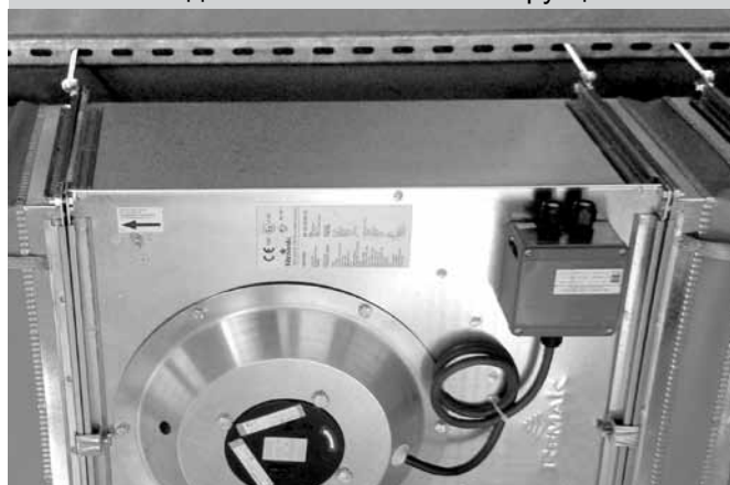
Рис. 11 – подвеска на вспомог. конструкцию
