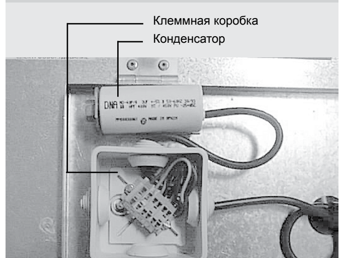
Рис. 9 - пластмассовая клеммная коробка
