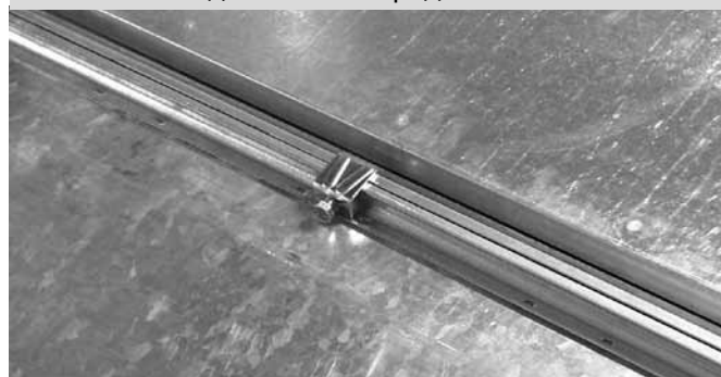
Рис. 13 – соединение посередине скобой
